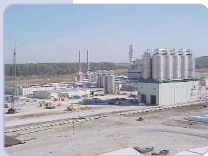
Cargill-Dow-Bioraffinerie, Nebraska, USA
